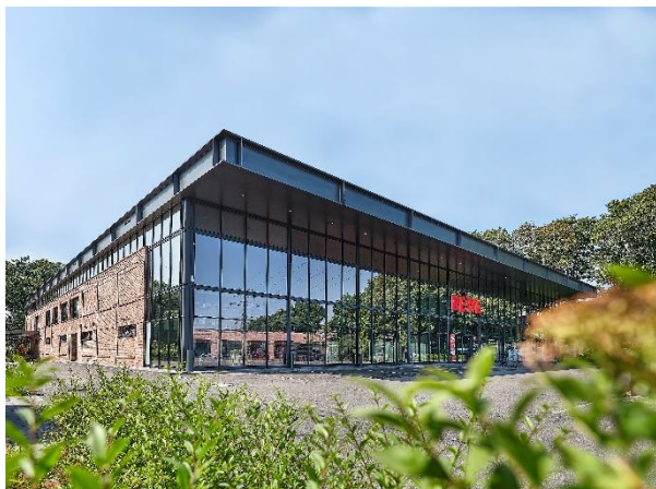
[Stellingwerf Höfe_heroal C 50_Glasfassade]
